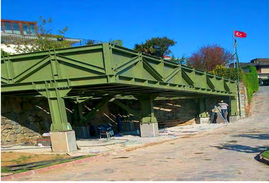
Usta İnşaat Bahçe Dolgu Otopark Projesi 30 ton Çelik Konstrüksiyon İmalat ve Montaj Çalışma Faaliyetlerimiz Garden Fill Car Park Project 30 tons Steel Construction Manufacturing and Installation Work Activities
