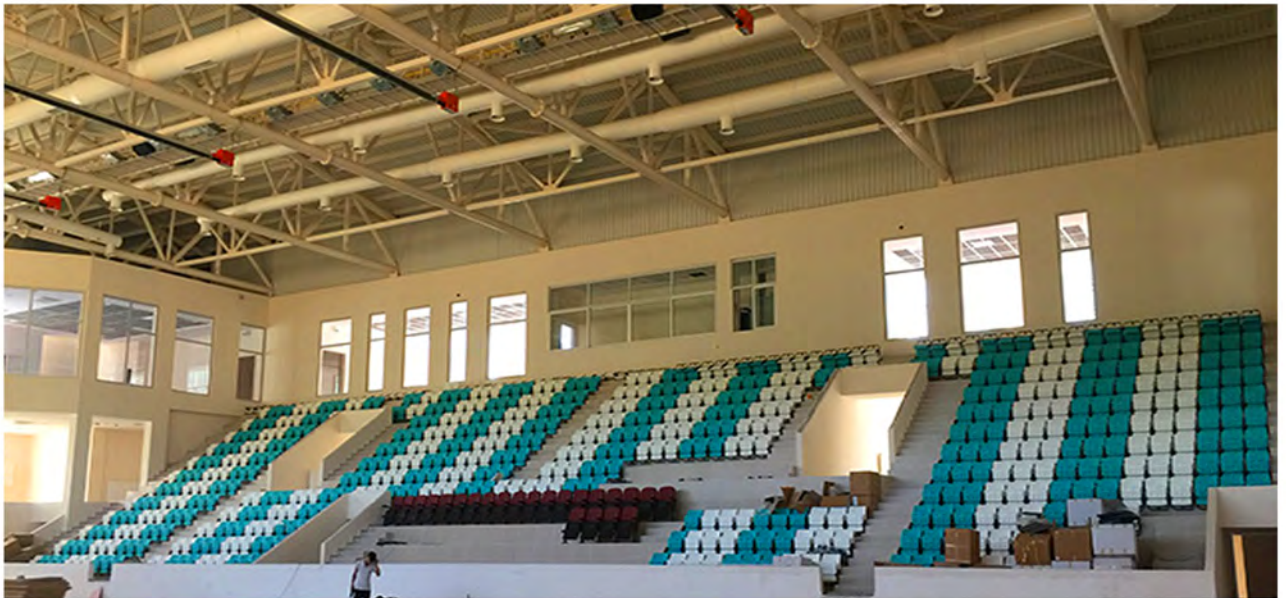
SİNOP BOYABAT SPOR KOMPLEKSİ 85 ton Çelik Konstrüksiyon İmalat Montaj Çalışma Faaliyetlerimiz SİNOP BOYABAT SPORTS COMPLEX 85 tons Steel Construction Manufacturing Installation Work Activities
